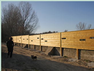
Construcció d'un aguait per a ocells davant de la colònia d'ardèids d'Espadamala de Baix (Torelló). Foto: Laia Jimenez-CERM
