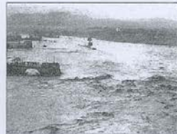
El Ter amb el pont Nou destruït, a Roda
