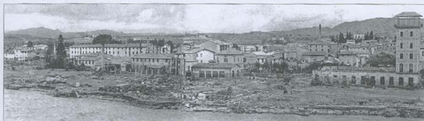
La femina de Manlleu va canviar completament en tan sols uns hores: fàbriques com les de Can Serra i Conductors Elèctrics Roqué van quedar devastades i el mateix va passar amb els habitatges.
