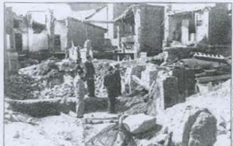
El carrer Enric Delatru va ser un dels punts més afectats de la vila
