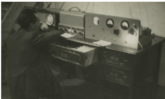
3 - Ràdio Manlleu – Joan Carrera fent ajustaments tècnics. El sintonitzador i l'amplificador permetien emetre el senyal de la ràdio. Es va instal·lar una línia de telèfon directa de l'emissora a casa del tècnic Joan Carrera, amb aparells procedents de la primera central manlleuena. Any 1951. Autor: Valls. Fons: família Carrera.
