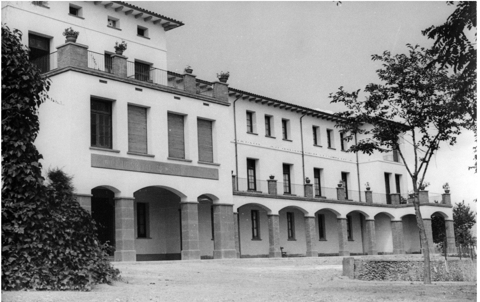
Edifici del segon hospital, inaugurat l'any 1951. Autor: X. Valls. Arxiu Valls
