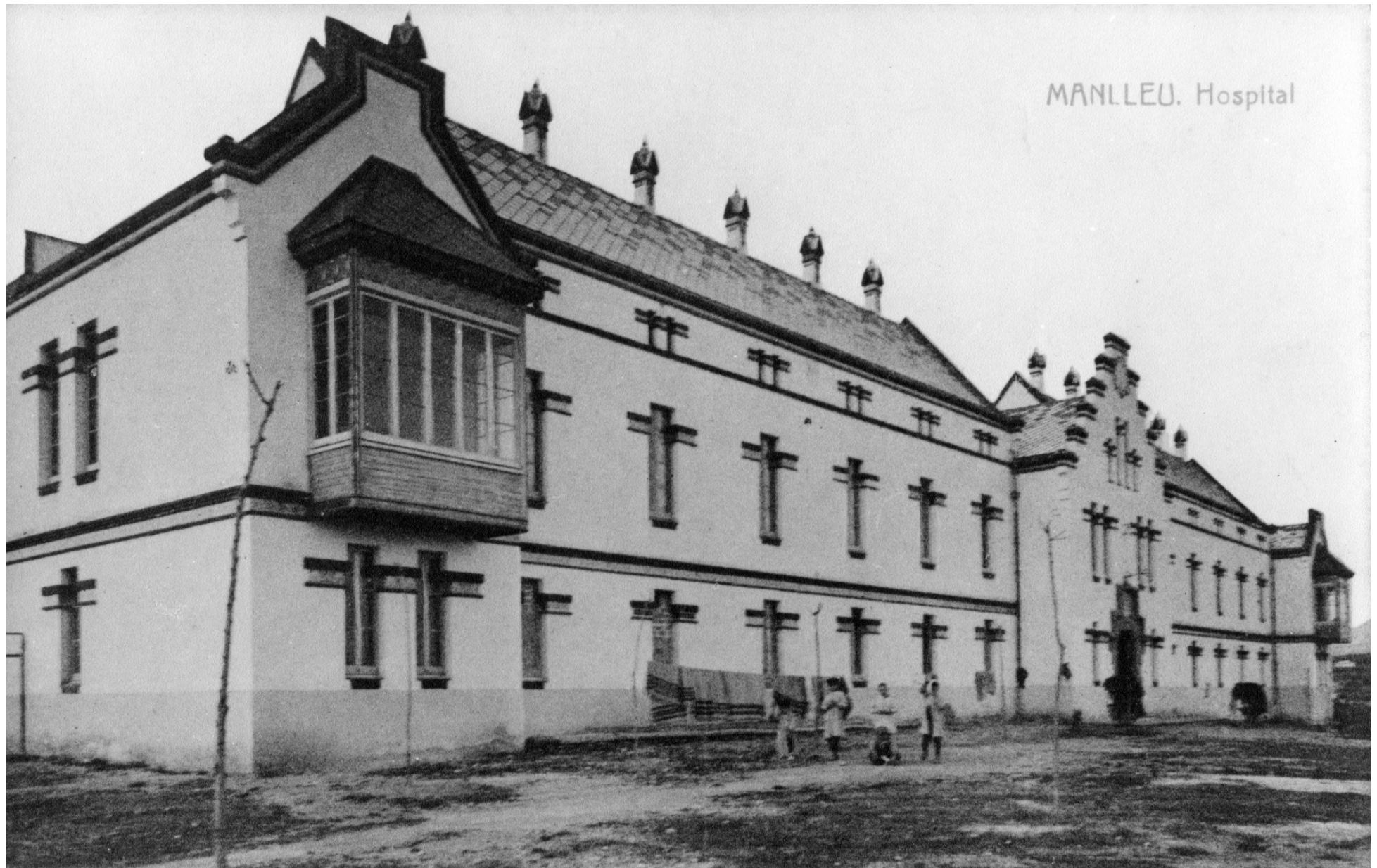
Façana principal de l'hospital inaugurat l'any 1913. Autor: Lluís Coll. Arxiu Valls
