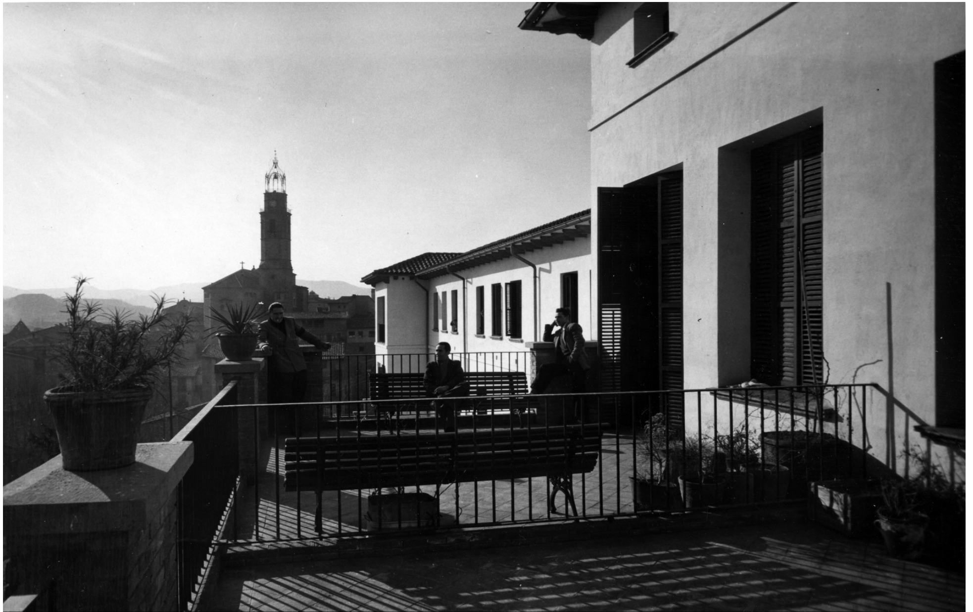
Terrasses del segon pis de l'hospital. Any 1953. Autor: X. Valls. Arxiu Valls
