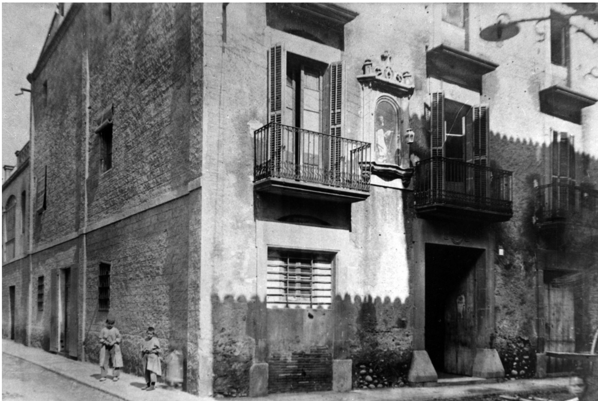
El primer hospital es trobava en aquest edifici de la cruïlla del carrer St. Domènec amb St. Ferran. Any 1905. Arxiu Valls
