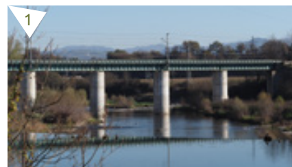
Resclosa de la Teula i pont de la via del tren.
