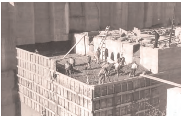
La construcció d'infraestructures (ferrocarril, carreteres i pantans).
