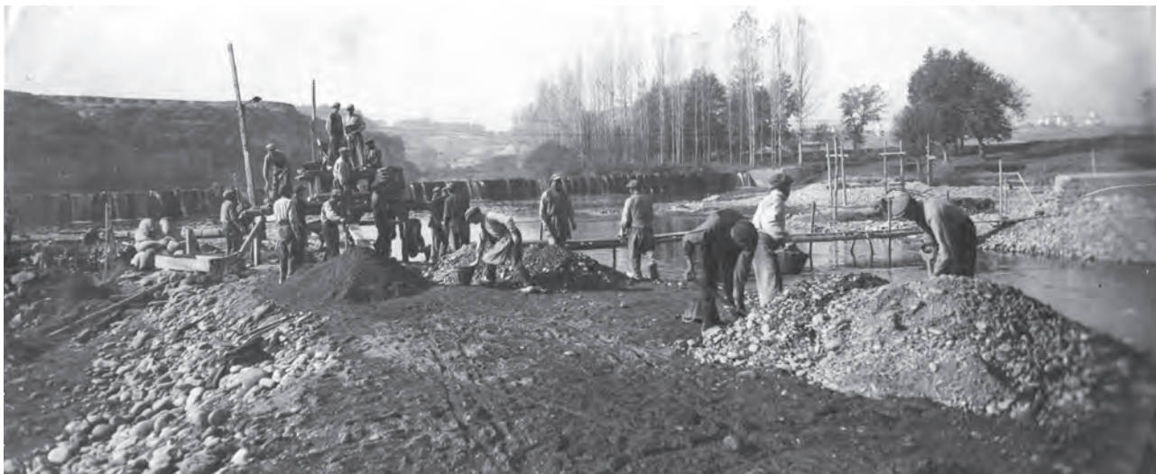
Obres de construcció de la nova resclosa (1926). Arxiu M. Dolors Pujol.
