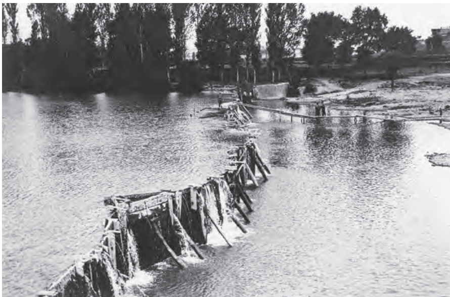
Antiga resclosa de fusta de la fàbrica (principis segle xx). Arxiu Rosanas.
