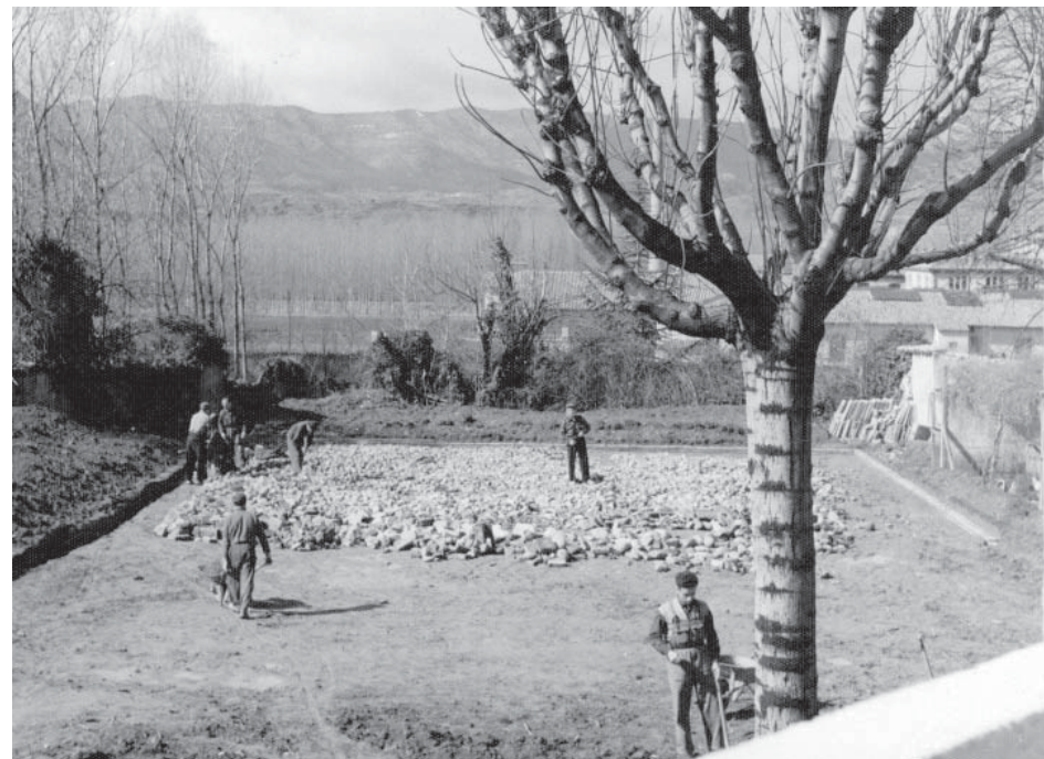
Obres a la Pista del Club. Any 1958.
