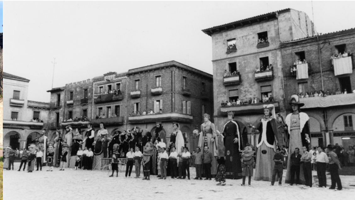
Concentració de gegants a la inauguració de les obres de la plaça Fra Bernadí el 12 d'agost de 1967. Autor: Jaume Salarich.
