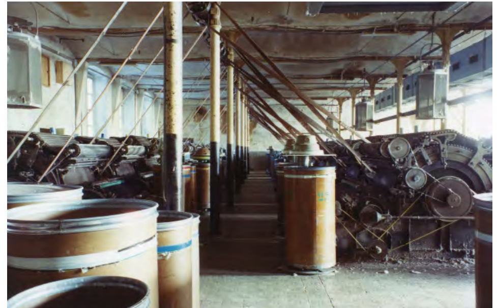
Sala de cardes de la fàbrica Nova on s'aprecia el sistema de corretges i embarrats que transmetia l'energia produïda per la turbina cap a les màquines. Dècada de 1990. Autor: Josep Maria Musachs. Procedència: Família Musachs.
