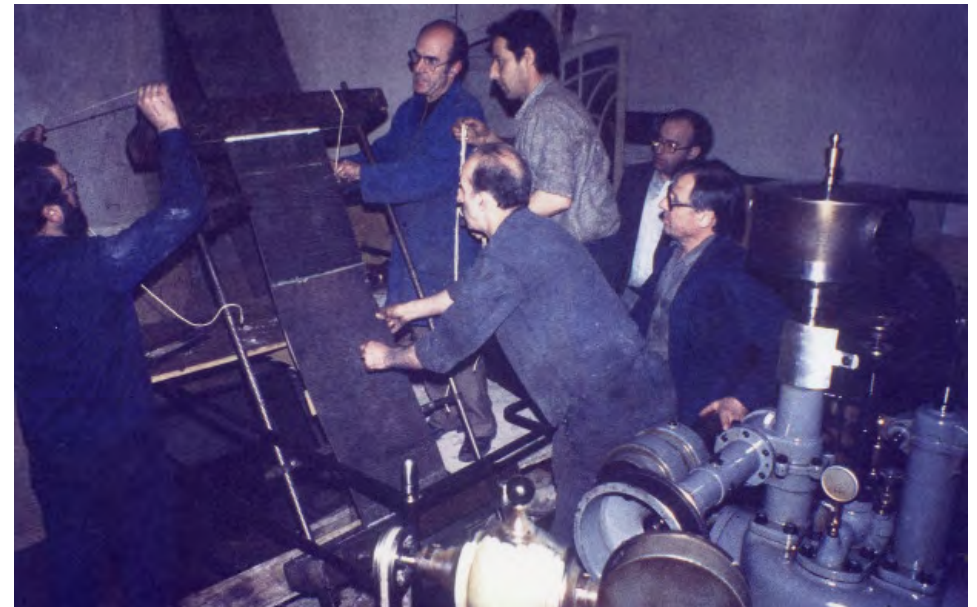
Mecànics de la fàbrica Nova escurçant, gràcies a un tensor, la corretja de transmissió de la turбина. A la part dreta de la fotografia es pot distingir la imatge parcial de la turбина. Dècada de 1980. Autor: Josep Maria Musachs. Procedència: Família Musachs.
