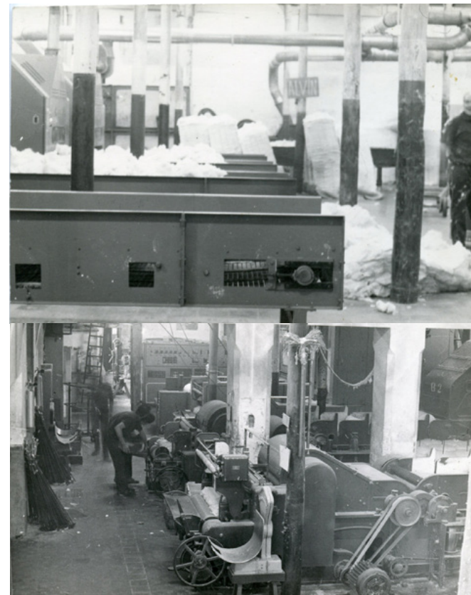
Imatge parcial dels batans que s'utilitzaven a Hilaturas Marquet. La fotografia mostra la telera del batan, part inicial del procés de filatura. Dècada de 1970. Autor: Josep Maria Castells Musachs – Arxiu família Musachs
