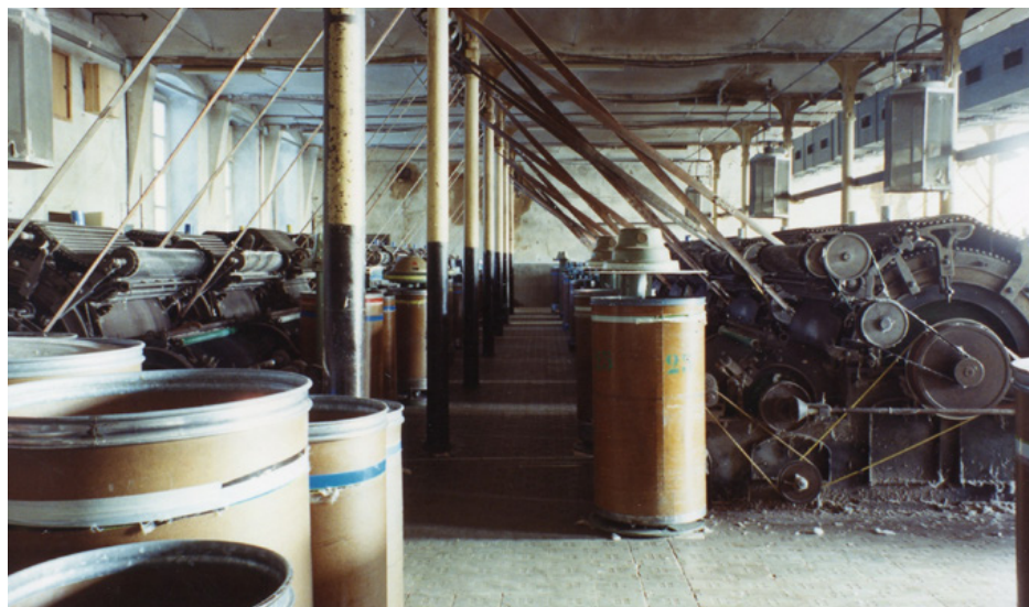
Interior d'una sala de la fàbrica nova a principis de la dècada de 1970. Concretament la sala de cardes i on encara es poden observar les corretges i embarrats que transmetien l'energia produïda per la turbina cap a les màquines. Autor: Josep Maria Castells Musachs – Arxiu Família Musachs.
