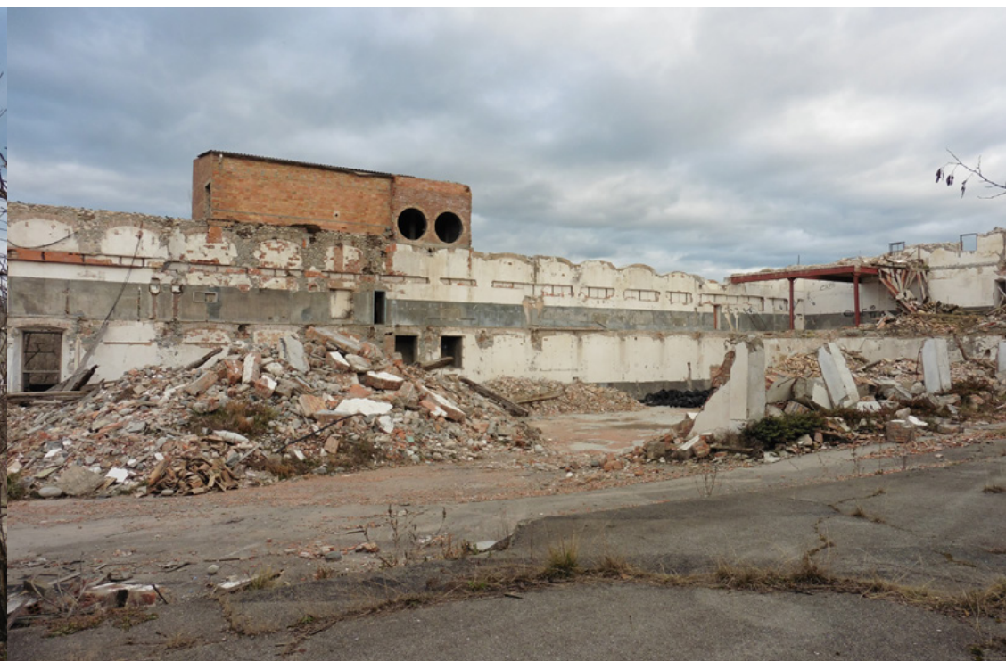
Nau de la fàbrica vella quan era enderrocada
