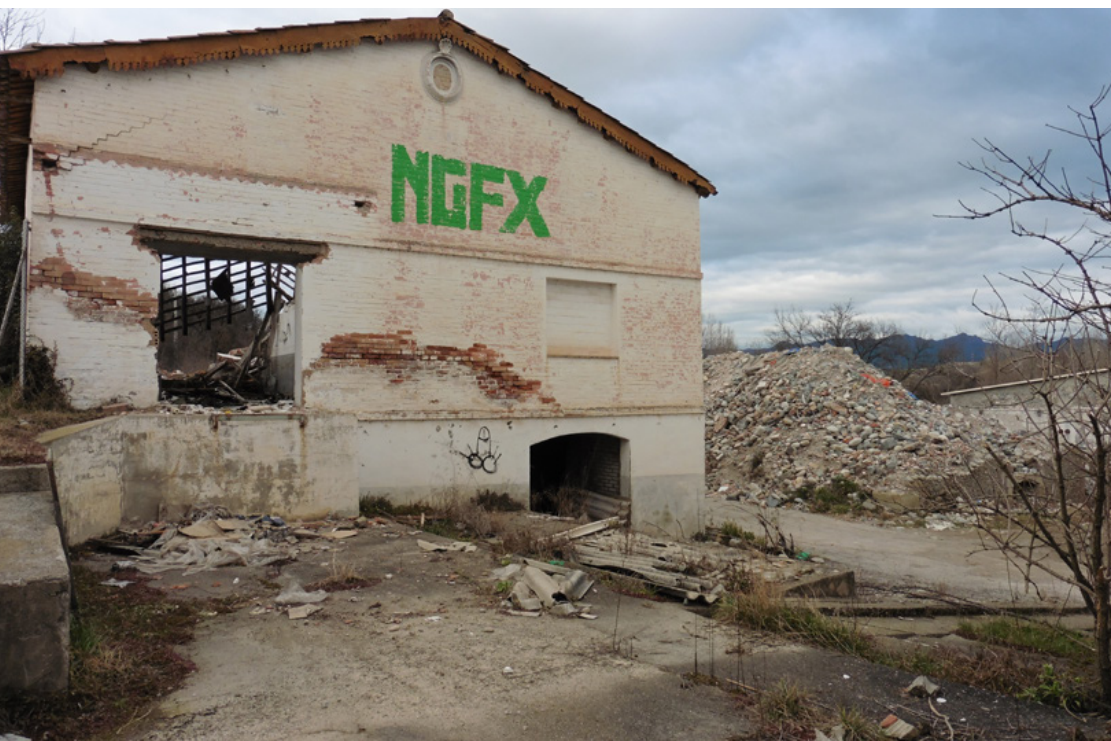
La nau de Can Rovira poc abans del seu enderrocament
