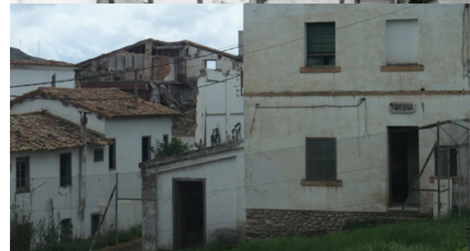
Porteria i habitatges de les fàbriques de Gallifa. En primer terme l'antiga porteria i al fons l'habitatge del director d' "Hilaturas Voltregà" i del manyà i l'escriptor d' "Hilaturas Marquet". Any 2014.
