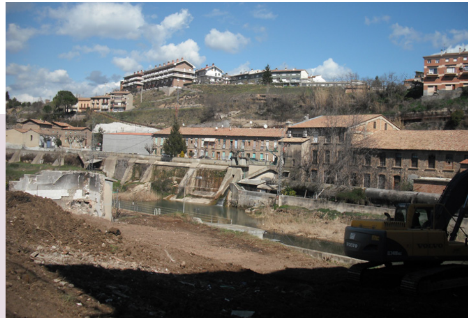
Enderroc de l'edifici de La Flor Obrera , 2013, arxiu personal de Ramon Campos Borrego.
