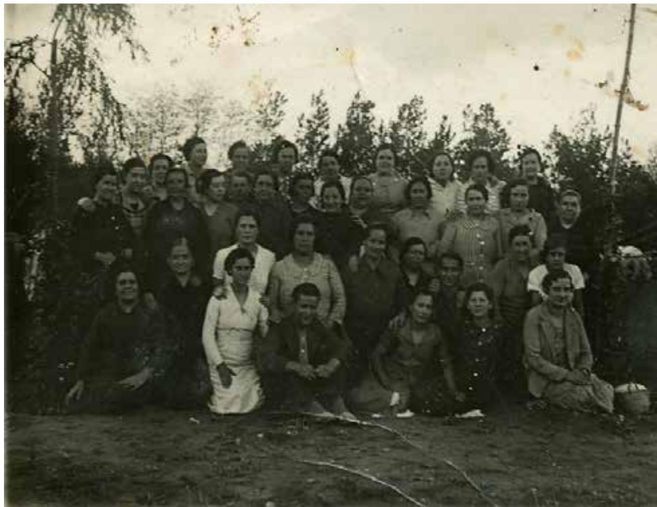
Treballadors de la dècada de 1940. Fons Salvador Martí - Museu del Ter.
