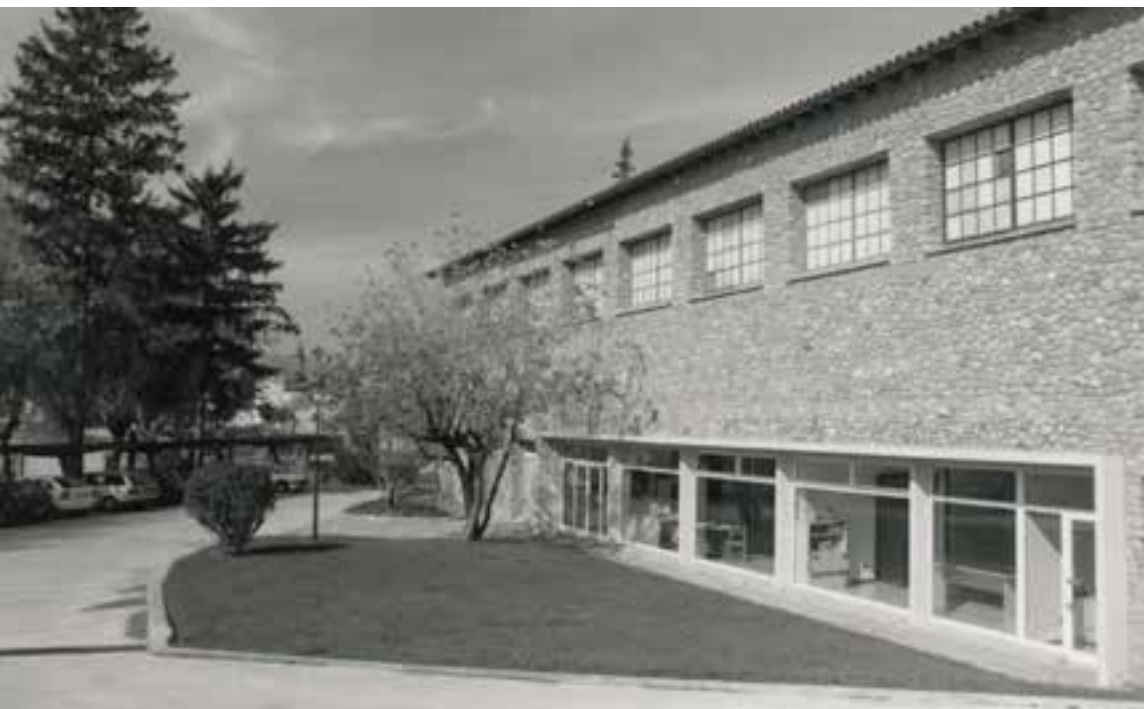
Entrada a les oficines i aparcament a Mimcord. Fons Cal Pastor.
