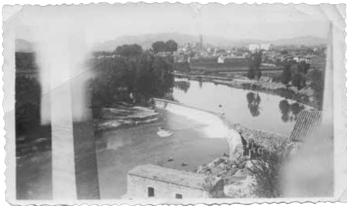
Restauració de la resclosa. Fons de la família Suriñach Albareda - Museu del Ter
